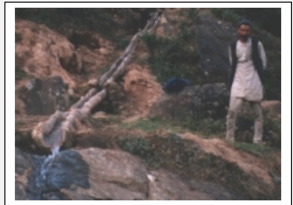
Figure 10-8 Un acueducto de madera sirve para conducir el agua a través de terreno disperejo
