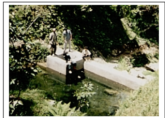
Figura 10-4 Se puede utilizar una represa/vertedero de concreto para formar un pequeño reservorio (Nepal).
