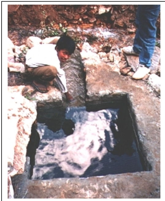
Figura 10-12 Una cámara de carga pequeña es apropiada para sitios donde hay suficiente caudal todo el año
