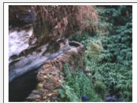
Figura 10-9 y Figura 10-10 demuestran un canal elevado que corre sobre un peinazo angosto, debajo de un paredón de roca. El canal tiene revestimiento de mampostería y está apoyado desde abajo sobre una pared alta hecha de piedras.
