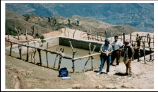
Figura 10-17 Un pequeño reservorio proporciona almacenaje de energía a bajo costo, que puede ser útil durante la temporada seca. (Sankhuwa Sava, Eastern Nepal)
