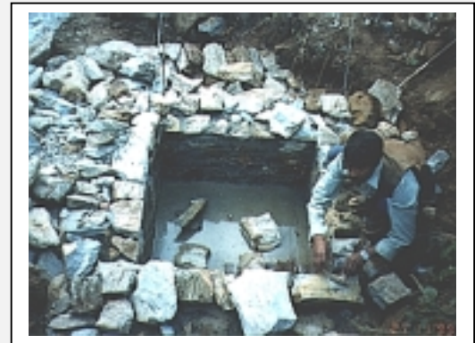
Figura 10-15 Construcción de una cámara de carga (Kushadevi, Nepal)
