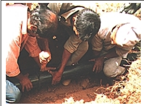
Figura 11-8 Se apretan ambos extremos de la tubería contra la placa caliente.
