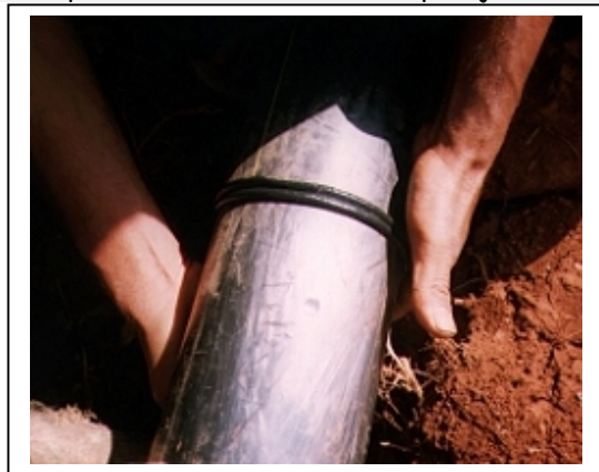
Figura 11-9 Se remueve la placa y se apretan las dos puntas una contra la otra, para formar un cordón parejo todo alrededor del tubo.
