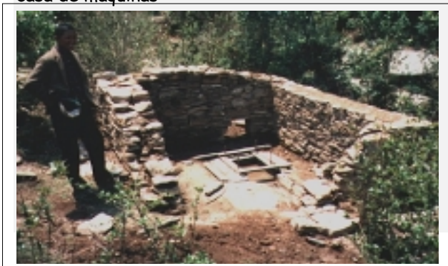
Figura 12-3 Casa de máquinas en vías de construcción, Nepal
