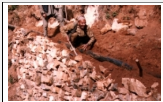
Figura 11-6 Los apoyos deberán ser debidamente reforzados antes de llenar la tubería con agua.
