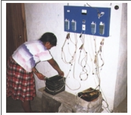
Figura 13-4 Cargando baterías con potencia hidroeléctrica (Peru)
