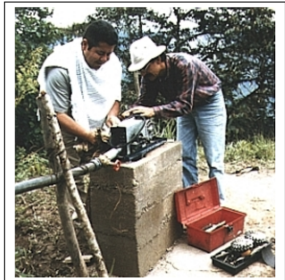
Figura 8-2 Un fabricante Colombiano (a la derecha) instala un sistema pico hidro de CD.
